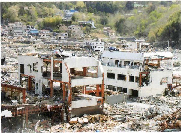
津波でビルの屋上に車がのっています（宮城県女川町）
